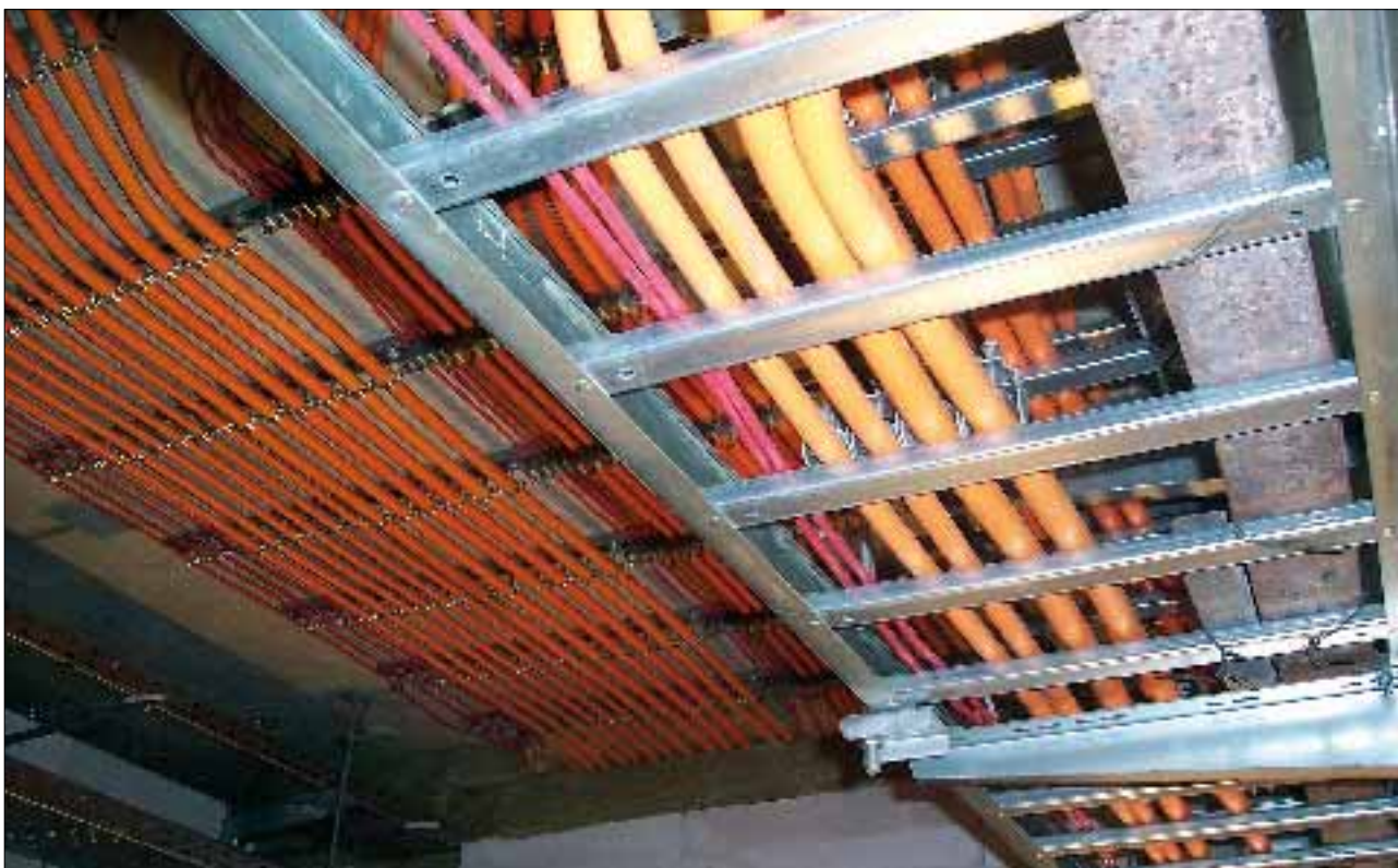
Obr. 5 Trasy káblov v skúšobnej peci
